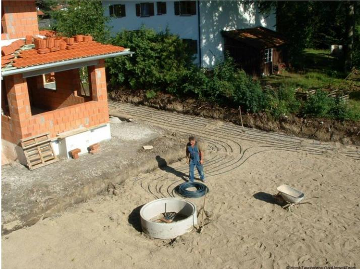
Bei großen Gartengrundstücken können auch Flächenkollektoren eingebaut werden, die Wärme aus den obersten Bodenschichten entziehen.
