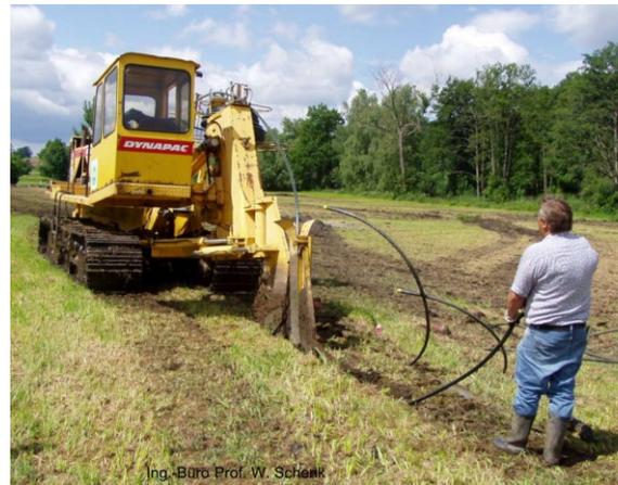
Neben dem offenen Verlegen, kann bei größeren Anlagen auch ein Einpflügen sinnvoll sein. So werden die nötigen Erdbewegungen minimiert.
