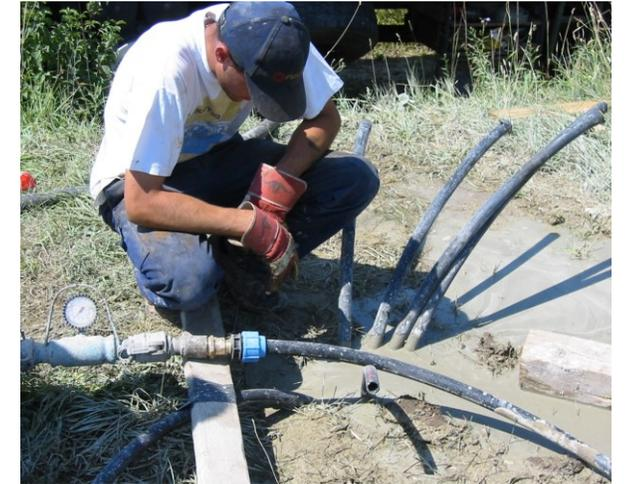
Der wichtigste Vorgang ist die Verpressung des Bohrloches mit einem speziellen Zement. Eine optimale Verpressung sichert eine gute thermische Anbindung der Sonde an das umgebende Gestein.
