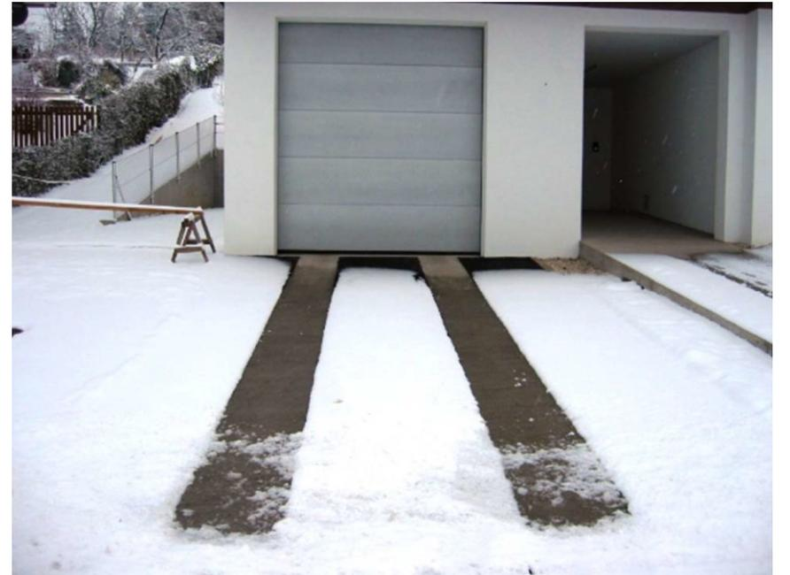
Sind die Heatpipes erst mal gebohrt und unter den Freiflächen verlegt, findet das Schneeräumen ganz von selber und komplett ohne zusätzliche Energie statt.
