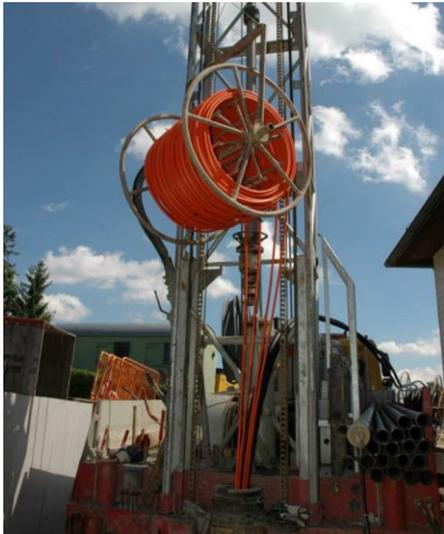
Die CO<sub>2</sub>-Sonden bestehen aus dünnen Kupferrohren, die mit Kunststoff ummantelt sind.
