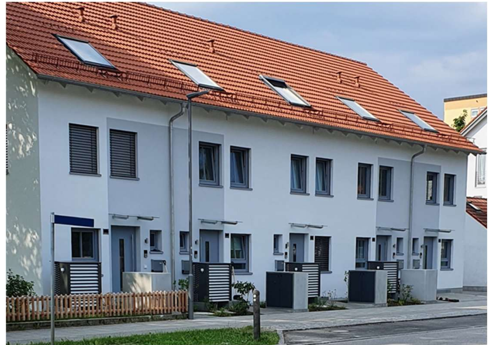
Monoblock (Außen) Reihenhaus
